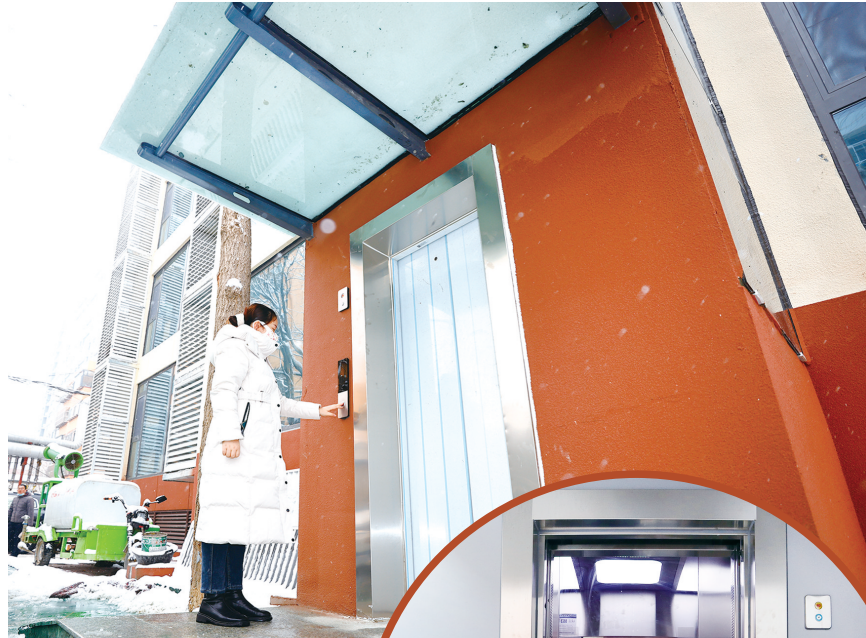
市建管处家属院老楼新装了电梯。 商景豪 摄
