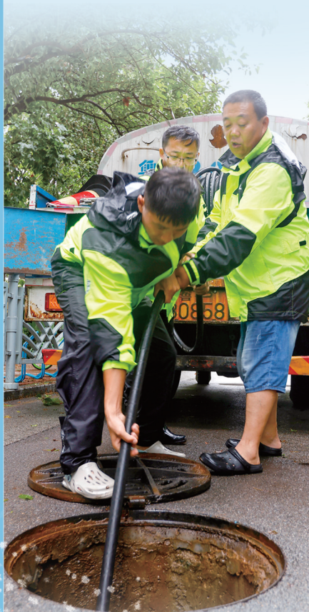
2021年7月29日,市政防汛队员疏通下水管道
