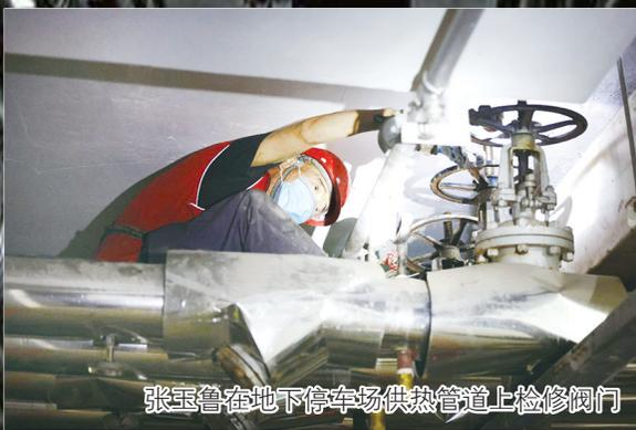
张玉鲁在地下停车场供热管道上检修阀门
