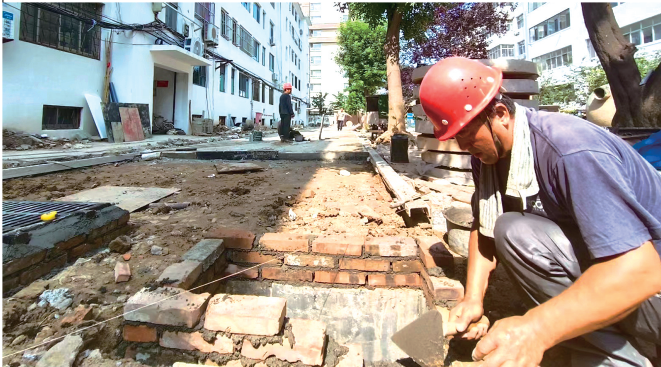
开发区聊建八公司家属院老旧小区改造现场
