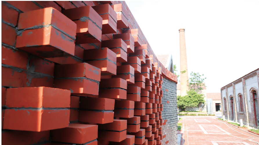
修缮改造完毕后的家具厂院落
