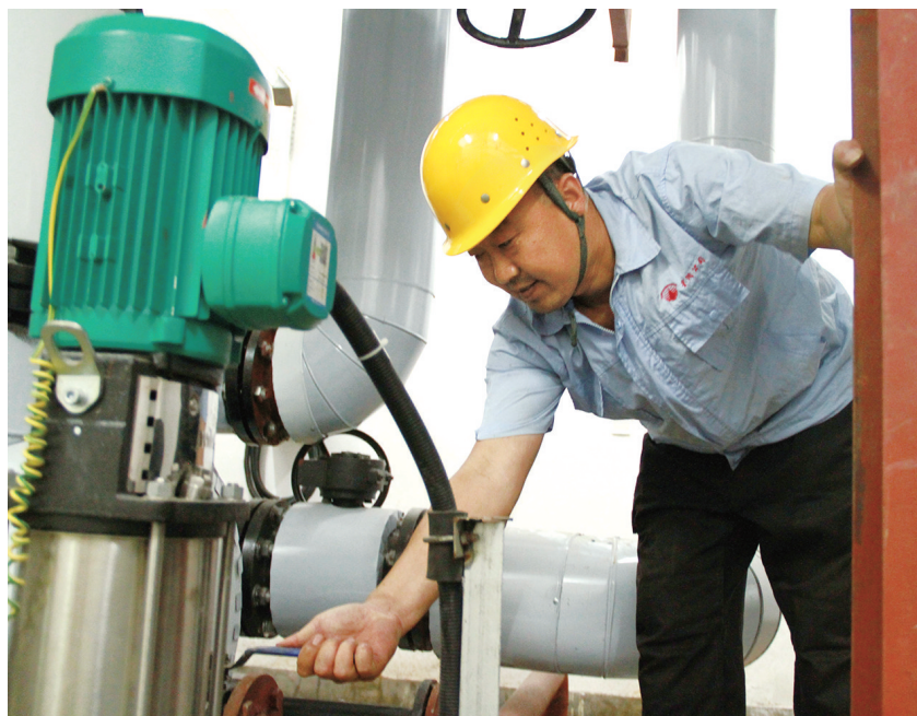
9月28日,在张庄小区,肖邦超正在冲洗管网
