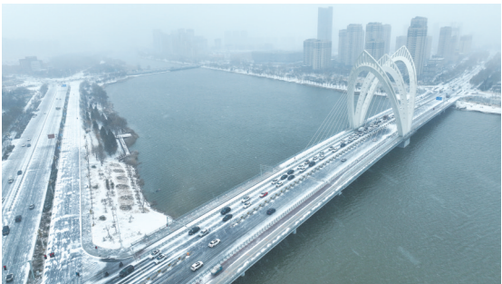
兴华路跨徒骇河大桥雪后别样风景 吴建正 摄
