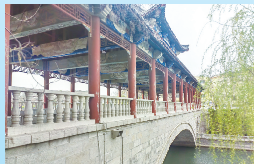
廊桥造型独特，廊柱上的山水彩绘栩栩如生
