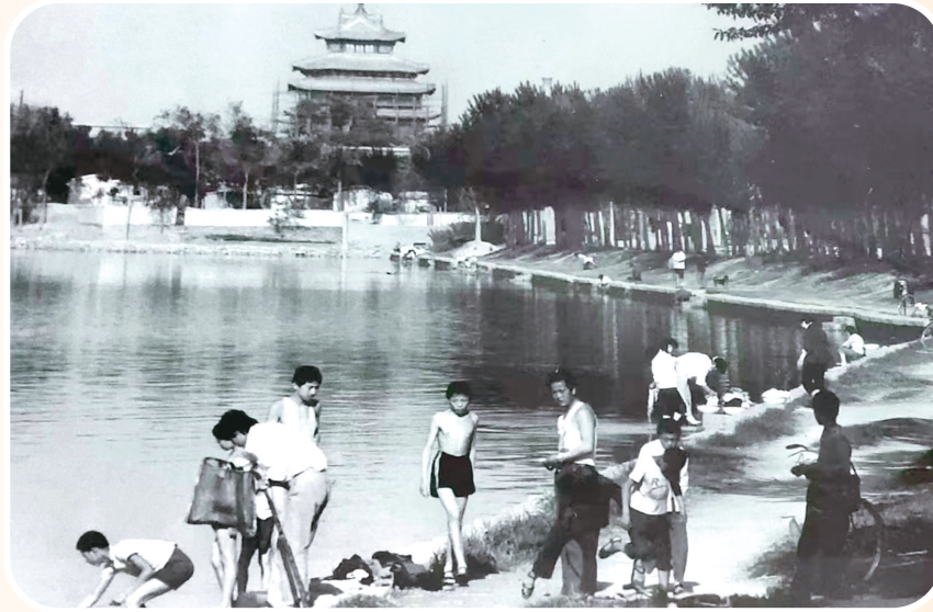
西关城门外景(聊城老照片博物馆供图)
