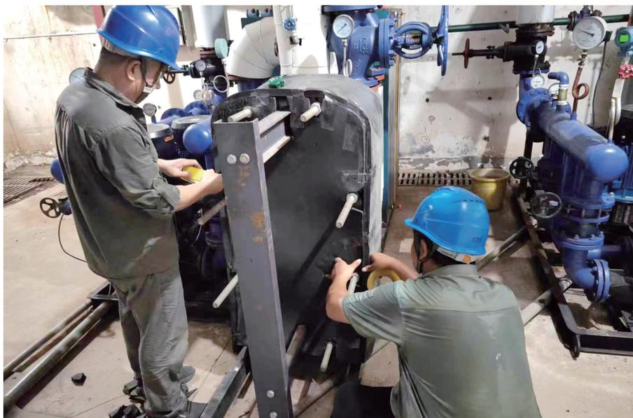
本报讯(记者 岳耀军 通讯员 苗跃)“在换热器外面包裹上一层保暖材料，就像给换热器穿上一件棉衣一样，可以减少热损耗，提高换热效率，保障供热质量。”8月23日，在市城区一换热站内，聊城热力一位工人师傅说。据悉，这项保温节能措施，在聊城供暖史上开创了先河。
