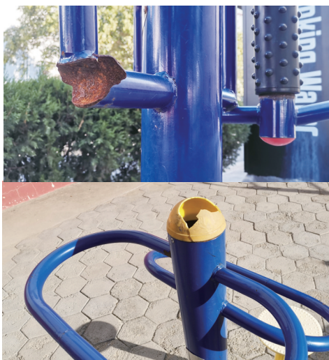
滨河花园南区已经损坏的健身器材
