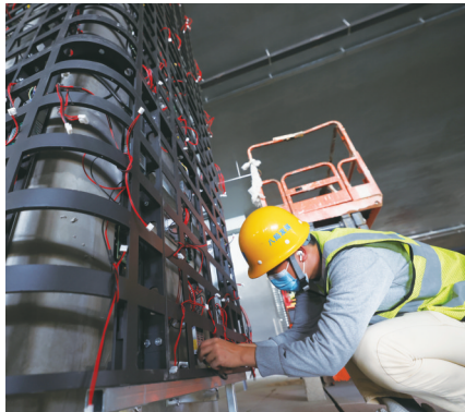
安装中的LED显示屏
