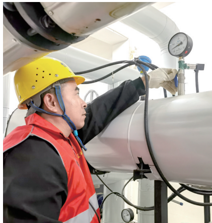
聊城恒润热力工作人员在开发区碧桂园·国岳府小区换热站试压。 受访单位供图
