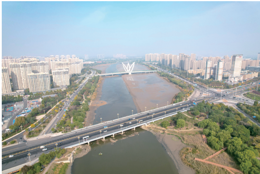
徒骇河城区段开展河道清淤施工
