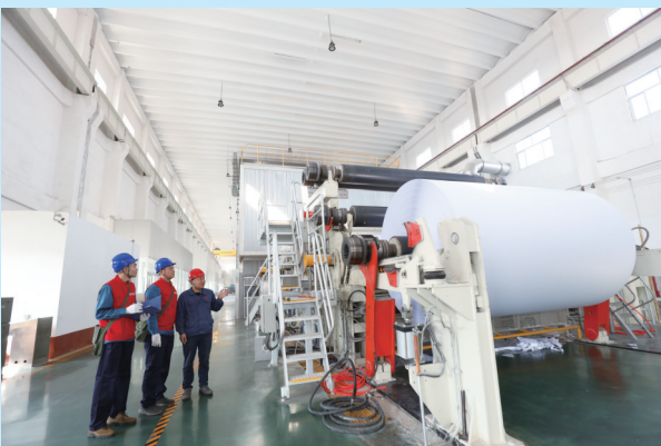
协助企业开展设备巡视消缺和用能诊断分析。 本报通讯员 曹务松 摄
