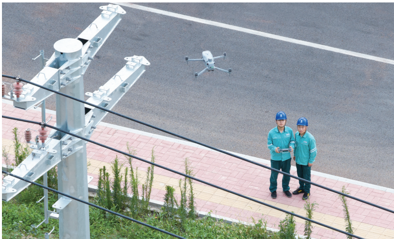
7月4日,国网聊城供电公司工作人员利用无人机对线路进行立体巡检。
