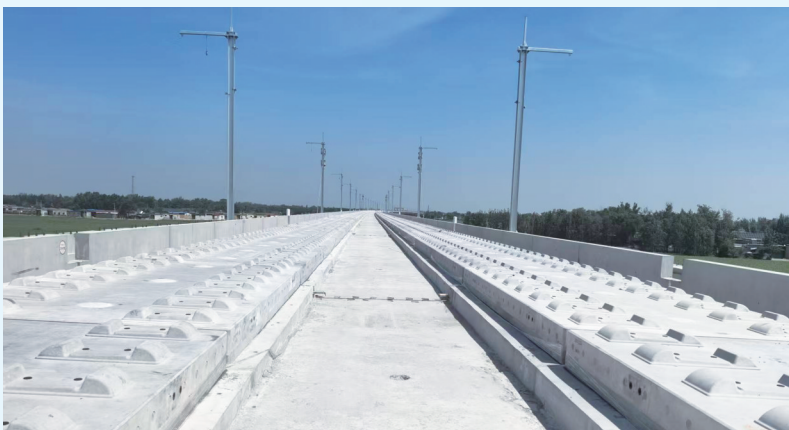
雄商高铁聊城段无砟道床
