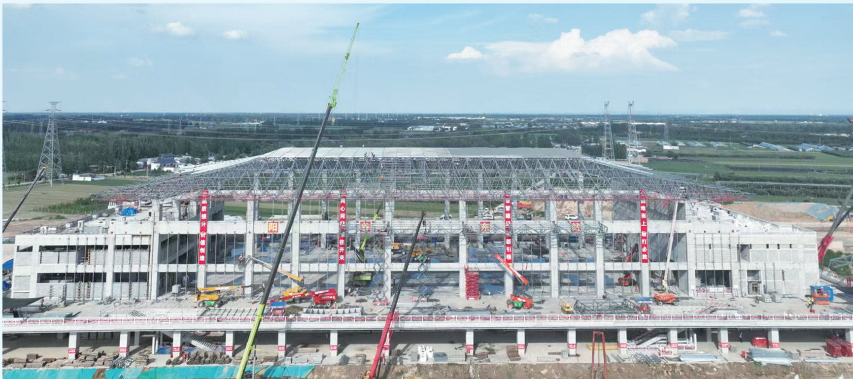
阳谷东站建设现场
