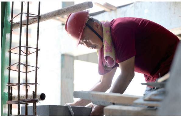
建筑工人在进行施工作业
