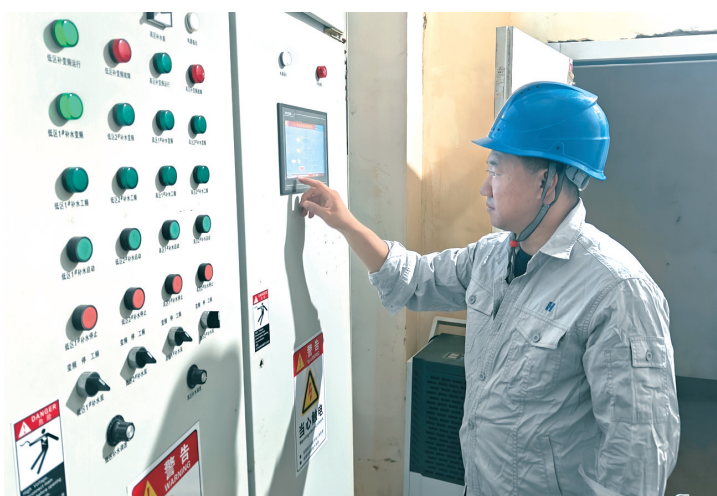
工作人员查看换热站注水打压情况
