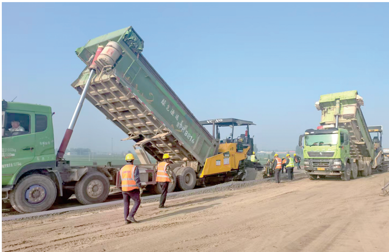
项目建设现场
