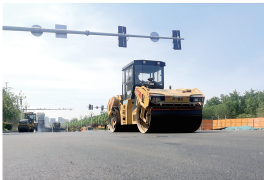
压路机在施工
