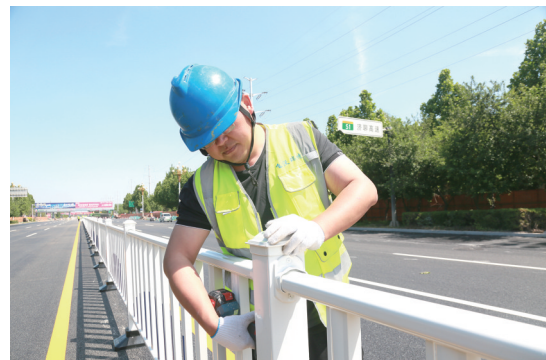
工作人员在安装护栏
