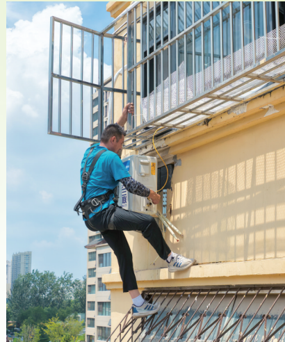
空调安装师傅顶着高温在户外作业
