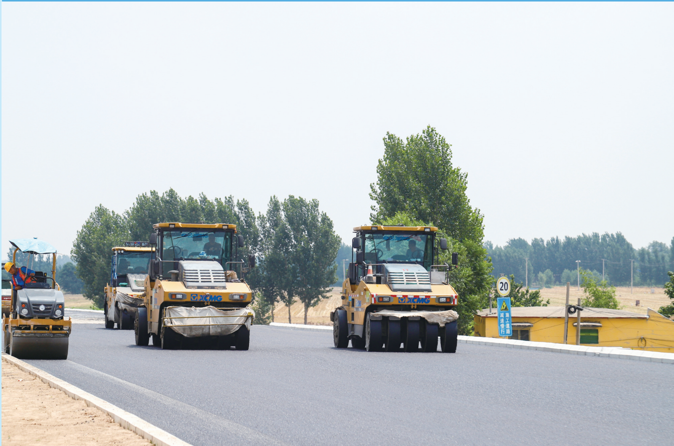
济东高速施工现场
