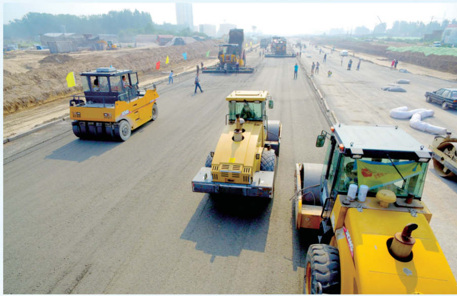
繁森路施工现场
