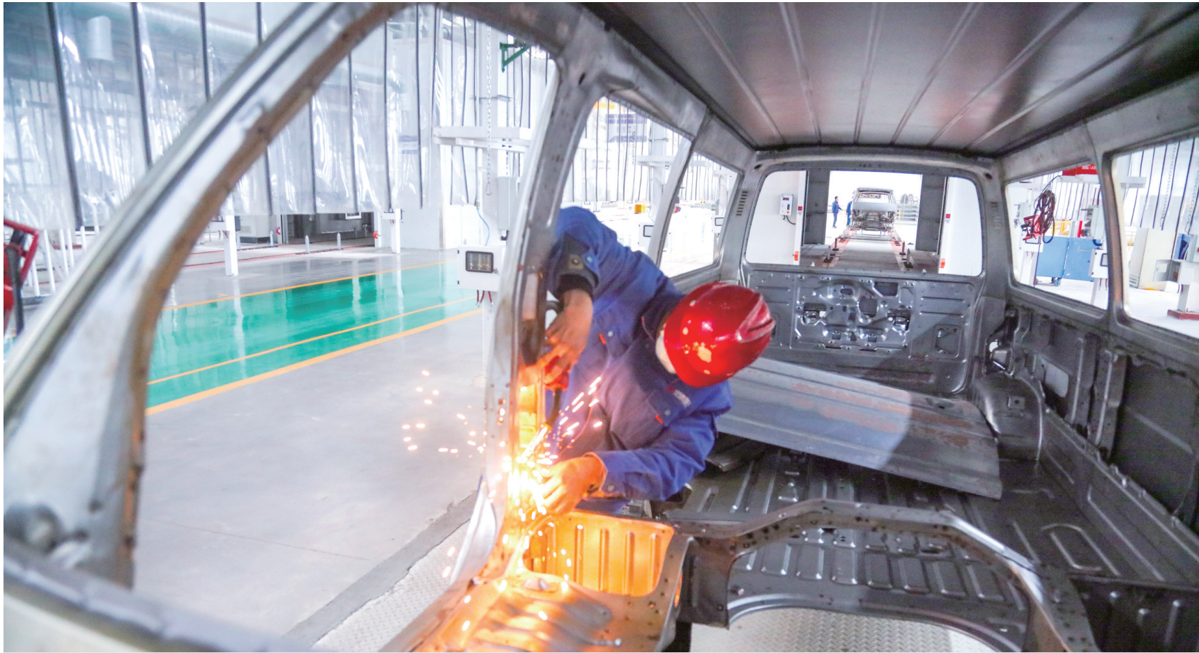
2月28日,在位于东昌府区的中通客车控股股份有限公司新能源汽车升级改造项目现场,工人正在进行焊接作业。该项目总投资12亿元,年产中型客车1.5万辆。
