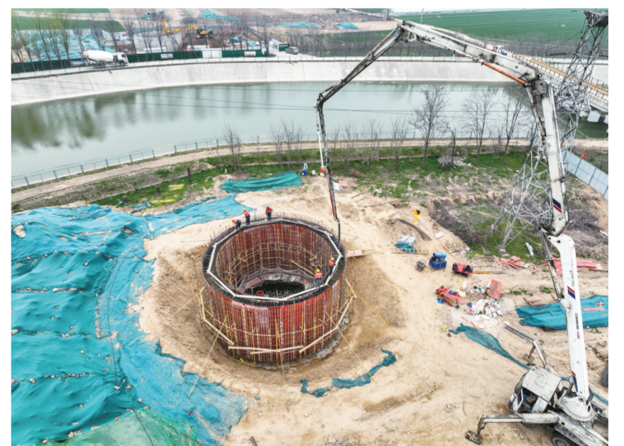
3月23日,在南部城区供热主管网及配套设施项目跨南北水北调工程施工现场,工人们正在紧张施工。据了解,建设中的供热主管网长度约为24公里,投资约7.6亿元。该段热水管网需要同时下穿南北水北调工程和京九铁路,是全线施工难度最高的特殊施工点。目前整个工程已全线开工,重要的节点已经完成工程量的50%,计划在今年7月份雨季来临之前完成大部分工程,2022—2023年供暖季前正式投入运行。
