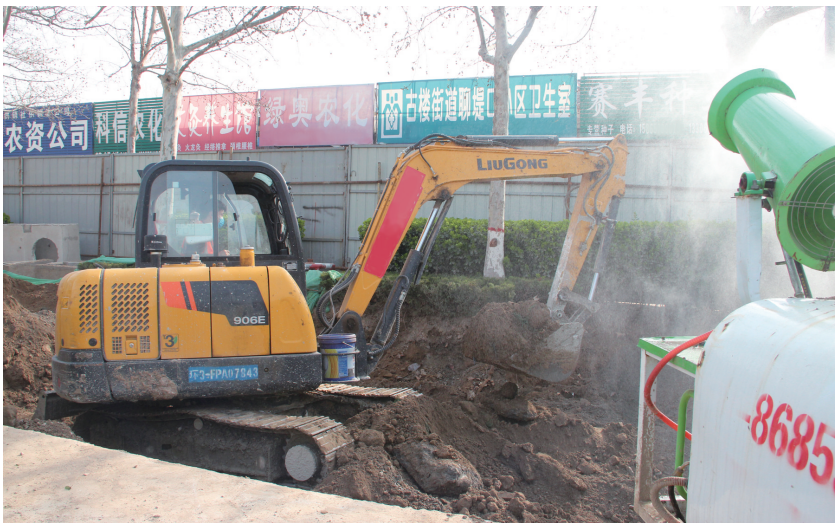
施工机械挖掘路面
