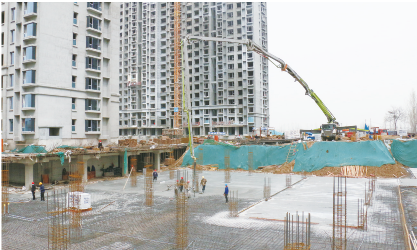
3月26日,在平区贺庄社区正在紧锣密鼓地建设。在平区高度重视民生工程,在贺庄社区建设中制定任务清单、责任清单、问题清单和详细施工计划表,对施工情况每天调度汇总,把好质量关,昼夜施工,抢抓工期,力争为群众交上一份满意答卷。
