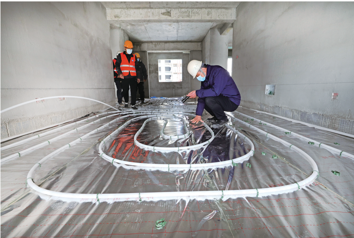
高新小镇施工现场,李振月检查水暖安装质量
