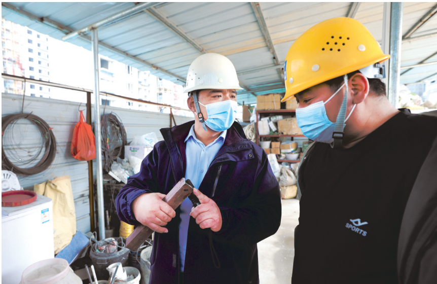
李振月与工地负责人探讨怎样更好地节省施工材料
