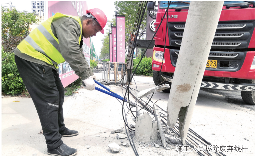
施工人员拔除废弃线杆
