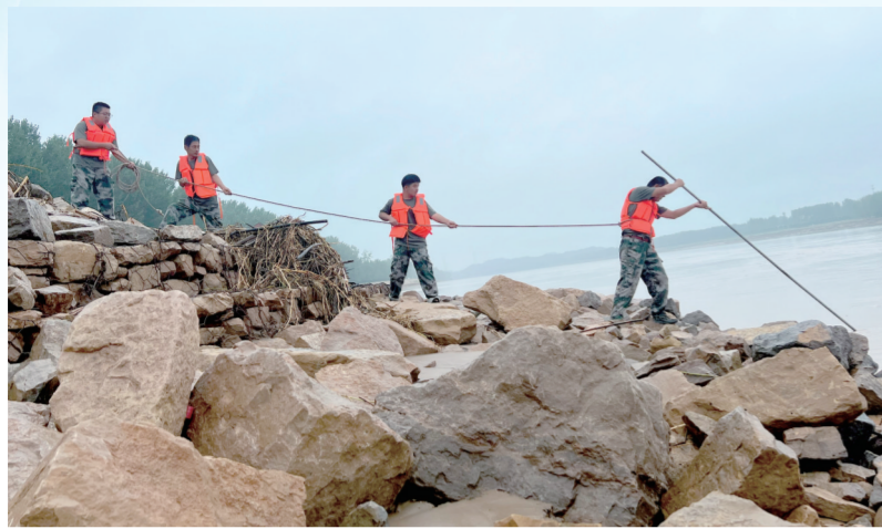
7月12日,东阿黄河河务局黄屯管理段的工作人员进行根石探摸
