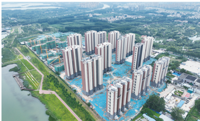
润泰投资有限公司邓楼安置区一期项目
