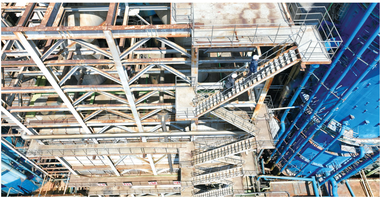
监测员们正在爬往监测平台
