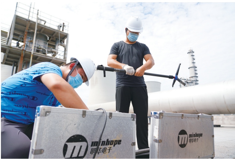
苏可(右)和同事正在安装废气监测设备
