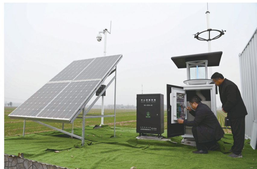
11月14日,在东昌府区广平镇四韩村高标准农田物联网监测系统建设现场,工人们正在施工。物联网监测系统对2万亩农田范围内的环境、苗情、虫情、鼠情、墒情等能做到实时监测预警,为科学种粮提供科学依据。
