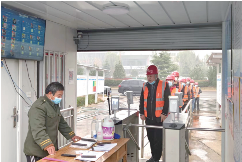
11月21日上午,在高新区东岳城市广场项目,建筑工人们排队进入施工现场
