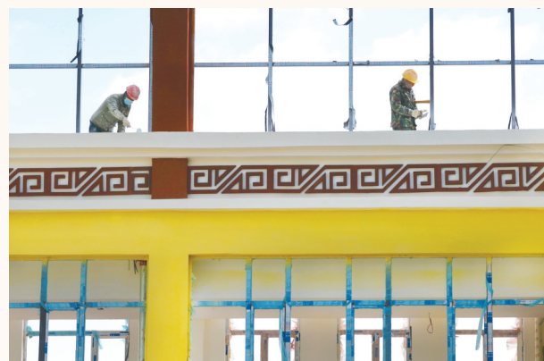
刚察县幼儿园建设项目现场
