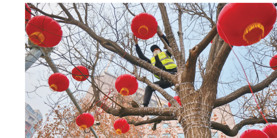
1月4日,施工人员在东昌路行道树上悬挂灯笼。春节临近,街头挂起的红灯笼和漂亮灯饰,让水城的年味变得越来越浓。
