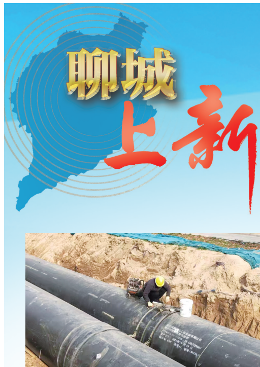
项目施工现场。■ 朱雨枫
