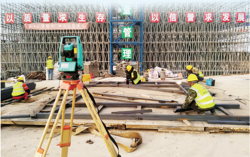
S242 临商线聊城绕城段项目建设现场
