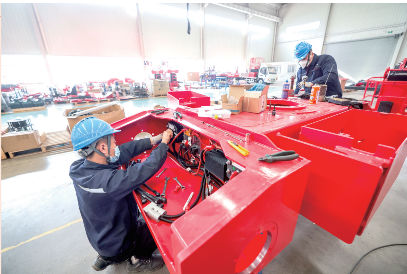
2月27日,在赫锐德(山东)智能科技有限公司高空作业平台制造焊接项目现场,工作人员在组装应用于机场、高铁站等多种领域的升降机底盘。项目全部投产后,年可实现销售收入1.5亿元,税收3000万元。
