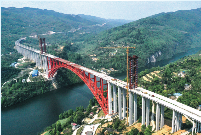
这是4月11日拍摄的德余高速乌江特大桥建设现场(无人机照片)。目前,由中交一公局承建的德余高速乌江特大桥项目建设进入冲刺阶段。德余高速乌江特大桥位于贵州省思南、石阡、凤冈三县交界处,是德江至余庆高速公路的重要控制性工程。
