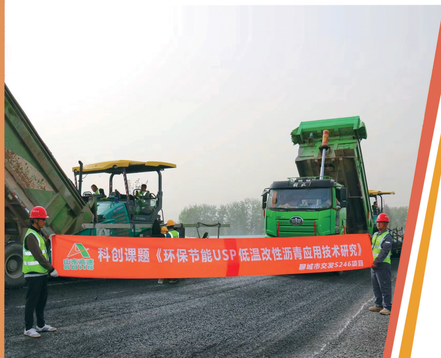
科创课题《环保节能USP低温改性沥青应用技术研究》在S246项目沥青路面下面层进行现场铺筑试验
