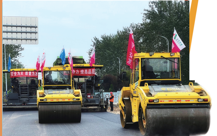
科创课题《环保节能USP低温改性沥青应用技术研究》在S246项目沥青路面下面层进行现场铺筑试验
