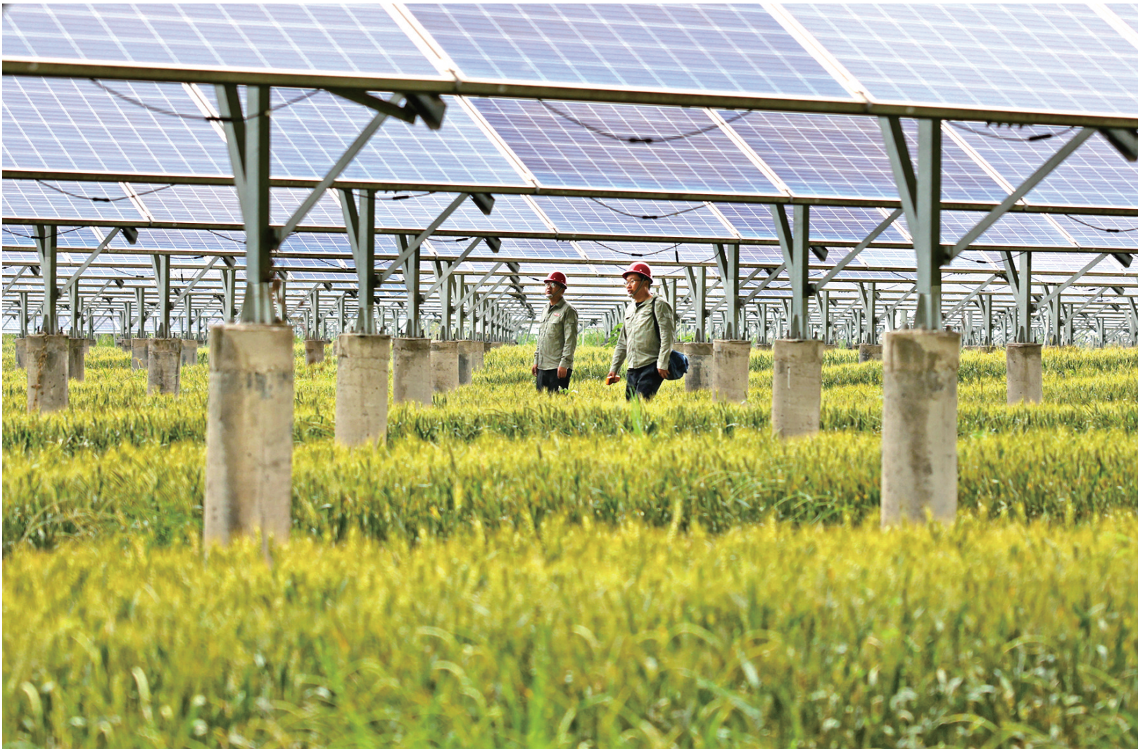
鑫佳源光伏农业有限公司工作人员巡查管护光伏设施
