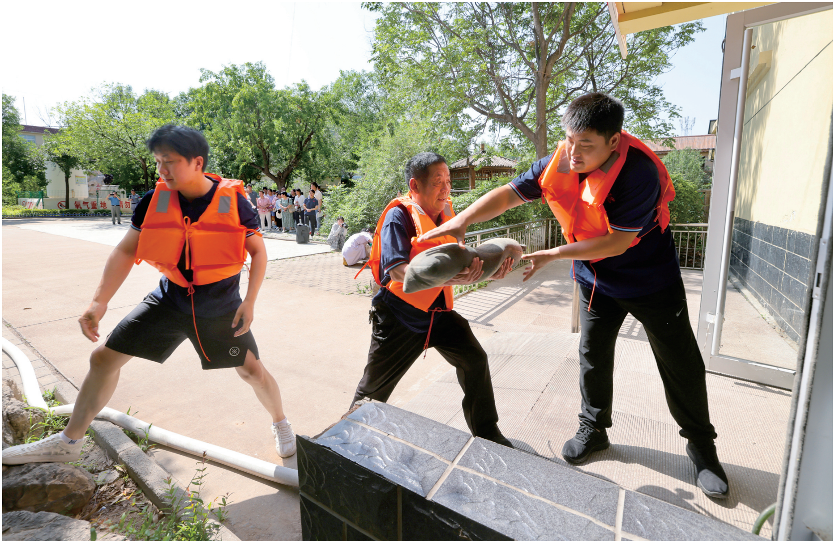
防汛抢险小组在一楼入口筑起防汛墙
