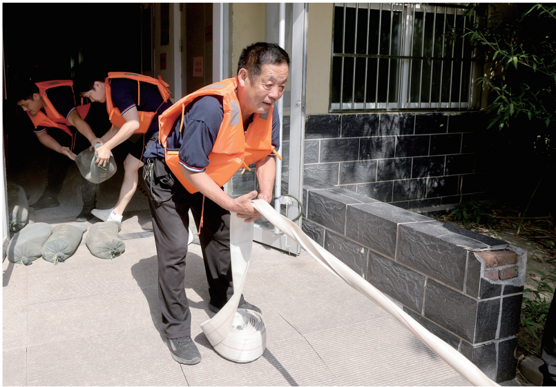
防汛抢险小组排除积水
