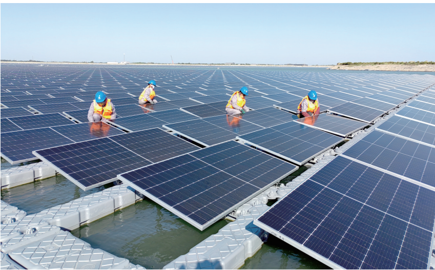
7月24日,国家能源聊城发电有限公司202兆瓦水库光伏电站,工作人员正在维护光伏组件。
