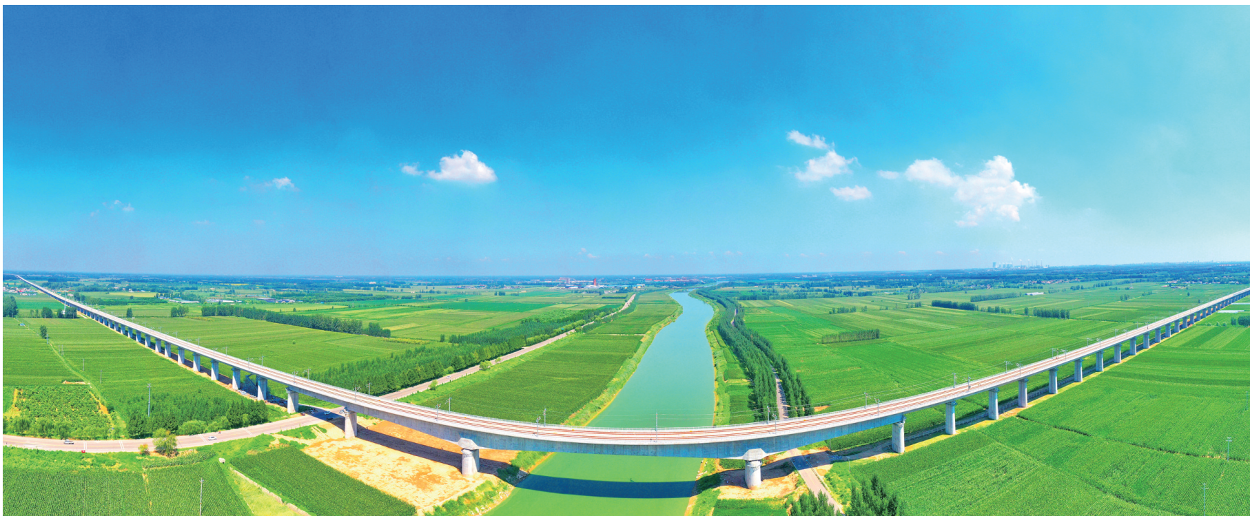
8月17日，济郑高铁聊城段景色壮美，宛如长龙卧波。济郑高铁聊城段全长115.3公里，经过三年多的紧张建设，主体工程全线贯通，已进入静态验收阶段，11月底正式开通运营。如今，聊城不仅有承东启西、连南贯北的区位优势，以高铁、高速、机场为主体的综合立体交通网也正加速成形。 ■ 本报记者 许金松
