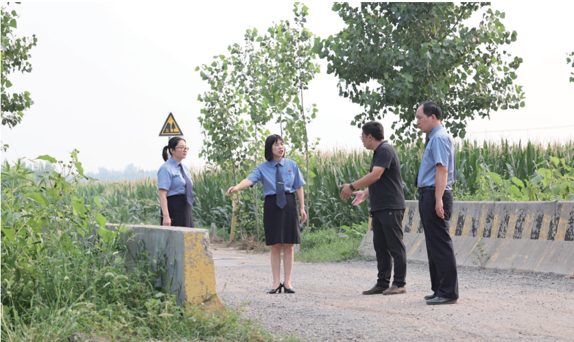
乡村振兴检察联络员和高唐县人民法院检察官一起察看桥梁改造情况
