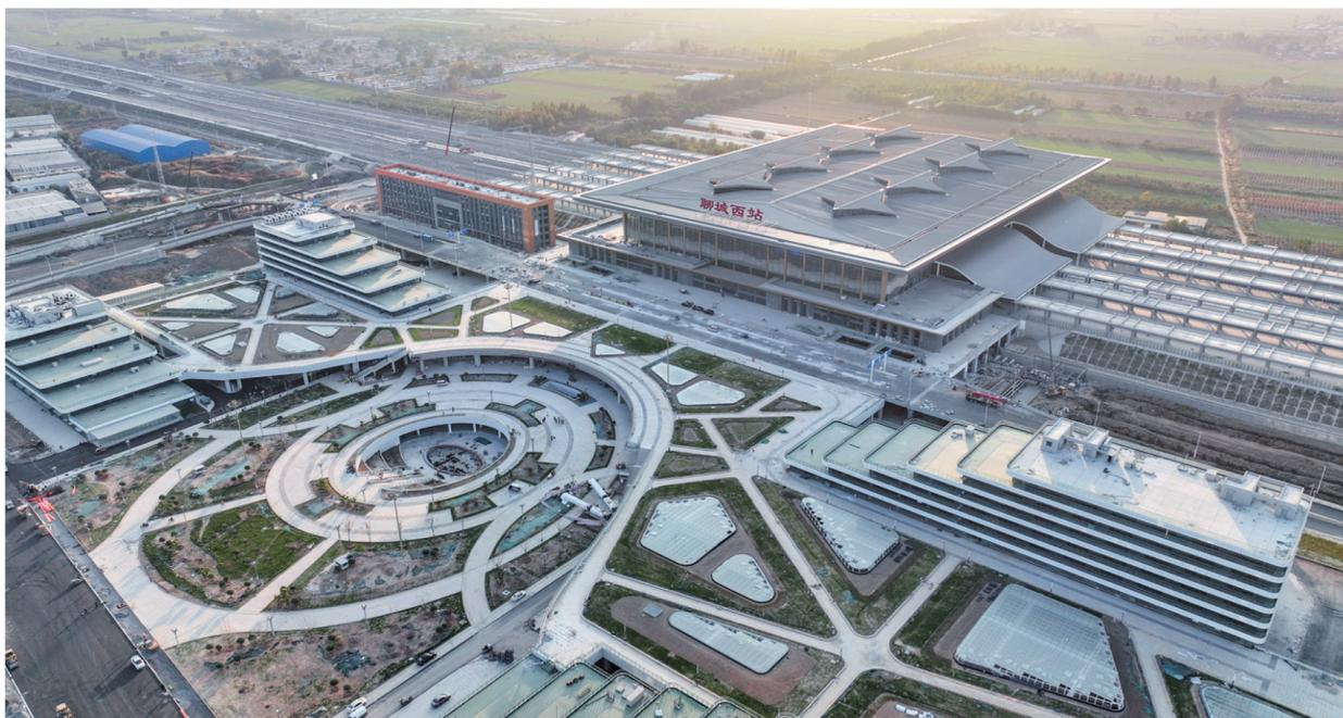
11月6日,在济郑高铁聊城西站建设现场,站房及配套基础设施已基本展露全貌,项目总体进入收尾工作。聊城西站配套基础设施项目地上建筑主要由落客平台、站前广场和7栋单体建筑组成,主要有公交枢纽、长途车站、配套建筑和市政建筑等;地下建筑主要有换乘大厅、社会车辆停车区、出租车蓄车场、配套设施等。
