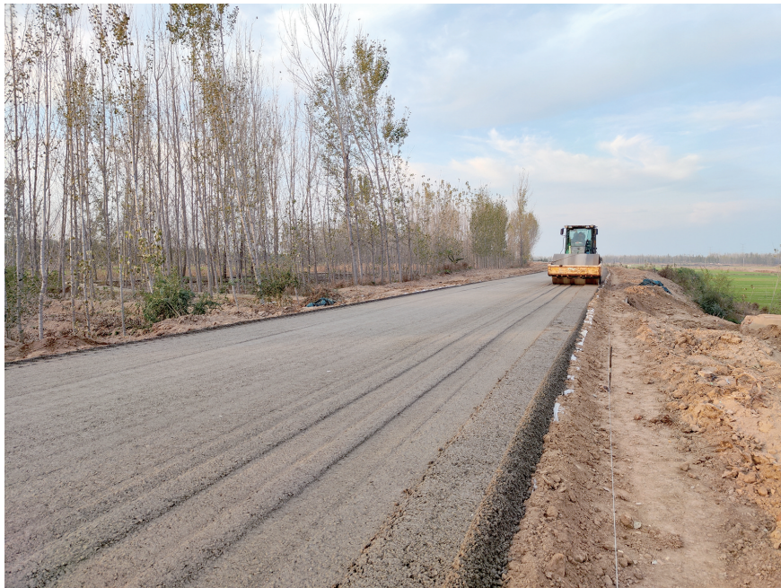
工作人员正在进行马颊河防汛道路硬化工程水泥稳定层施工
