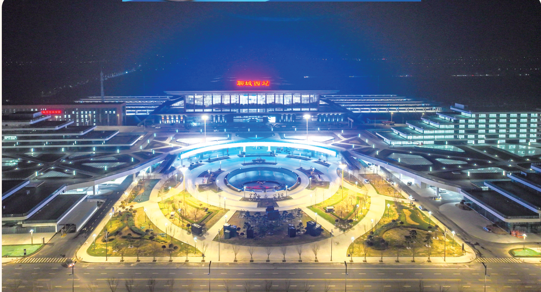
12月6日晚，济郑高铁聊城西站灯火璀璨。济郑高铁东接京沪高铁、西连京广高铁，中段在聊城西站与在建的京雄商高铁交会，是国家“八纵八横”高铁网的重要连接线。济郑高铁全线贯通运营后，将进一步完善区域路网结构，便利沿线人民群众出行，实现山东半岛城市群与中原城市群互联互通，对于推动黄河流域生态保护，促进区域经济社会高质量发展，具有十分重要的意义。
