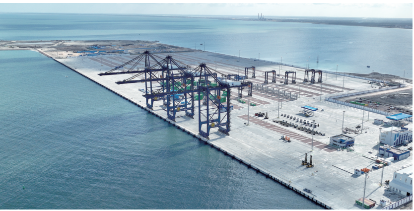
这是2023年12月1日在埃及亚历山大拍摄的阿布基尔集装箱码头(航拍照片)。埃及当地时间1月9日上午，满载2000个标准集装箱的中国籍货轮“中谷吉林”号停靠至埃及第二大城市亚历山大阿布基尔集装箱港口码头。这标志着由中国港湾工程有限责任公司(以下简称“中国港湾”)承建的阿布基尔集装箱码头项目已完成的600米码头岸线正式开港运营。
